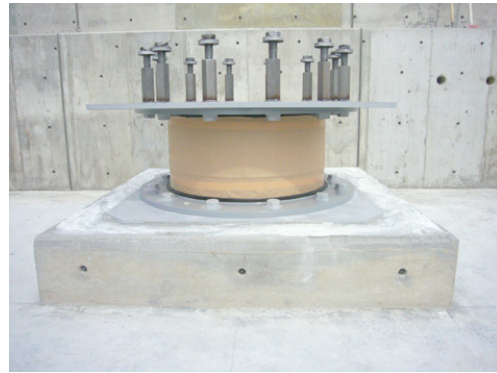
写真4 免震ゴム設置後の状況
