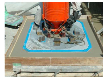
⑥グラウトの打設状況
