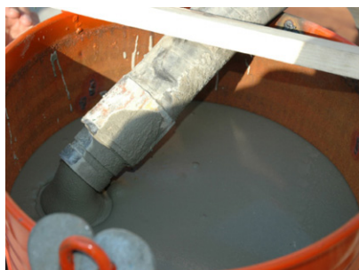
⑤グラウトのホッパーへの充てん状況 2
