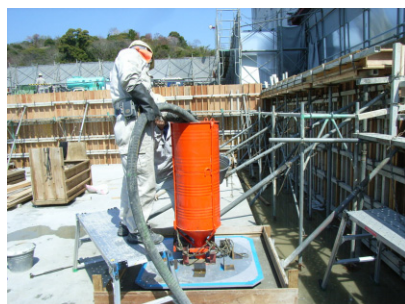
④グラウトのホッパーへの充てん状況 1
