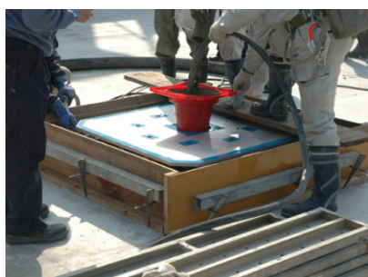
②下地コンクリートの打設状況
