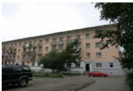
Photo 2 中国の設計・施工によるアパート（軒下壁面等に装飾がみられる）
