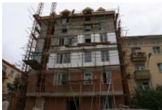
Photo 3 韓国企業により建設中のアパート（間仕切りには韓国で一般的なALCブロックが使われている）
