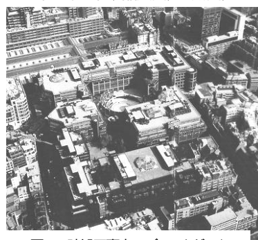
図-7. 建設中のブロードゲイト
