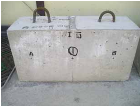
写真3 コンクリート表面の仕上がり状況 (コンクリート用型枠合板)
