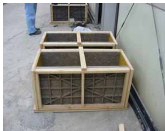
写真1 型枠の外観
