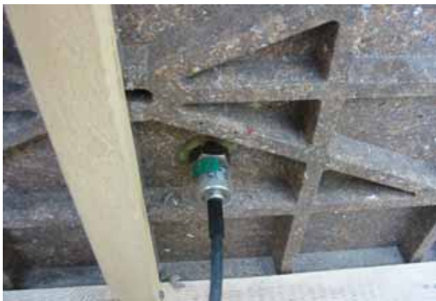
写真2 側圧計の設置状況
