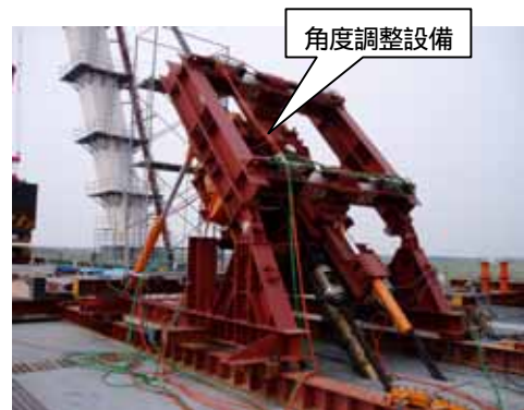
図 - 15 美原大橋の押し込み装置
