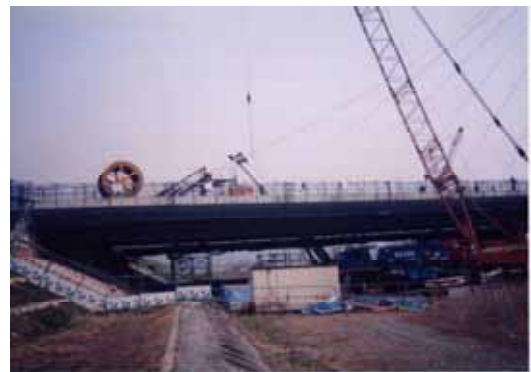
図 - 11 組み立て中の押し込み装置
