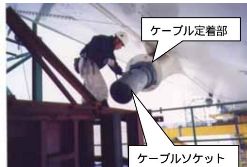
図-3 ケーブル端末定着部の状況
