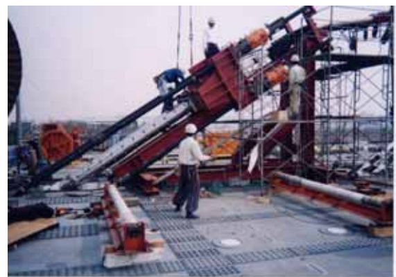
図 - 7 押し込み装置の全景
