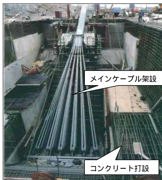
図2：ケーブル・チャンバー内で メイン・ケーブルの架設と コンクリート工事を平行して施工
