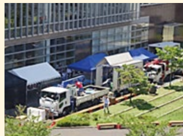
デモ施工全景
