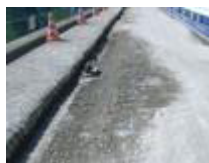
写真 1 橋梁床版の劣化
