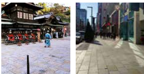
a) 愛媛県松山市の例 b) 東京都中央区の例 写真-1 電鉄敷石を利活用した自然石舗装
