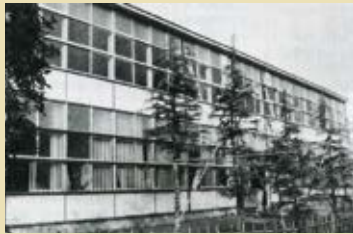
昭和32年竣工のプレハブA棟
